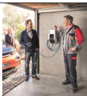
Przykład stacji ładowania zainstalowanej w garażu. (Fot.: Mennekes)
